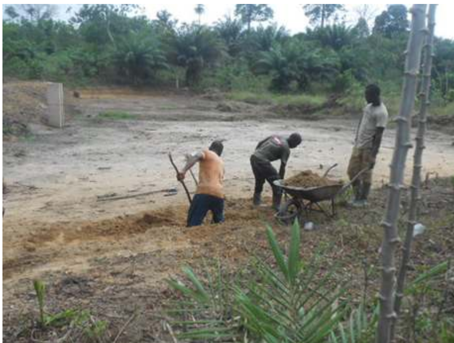
Figure 3a. Différents emplacements des sites piscicoles. Etang en construction au sein d'une plantation - Méagui / C.-O.
