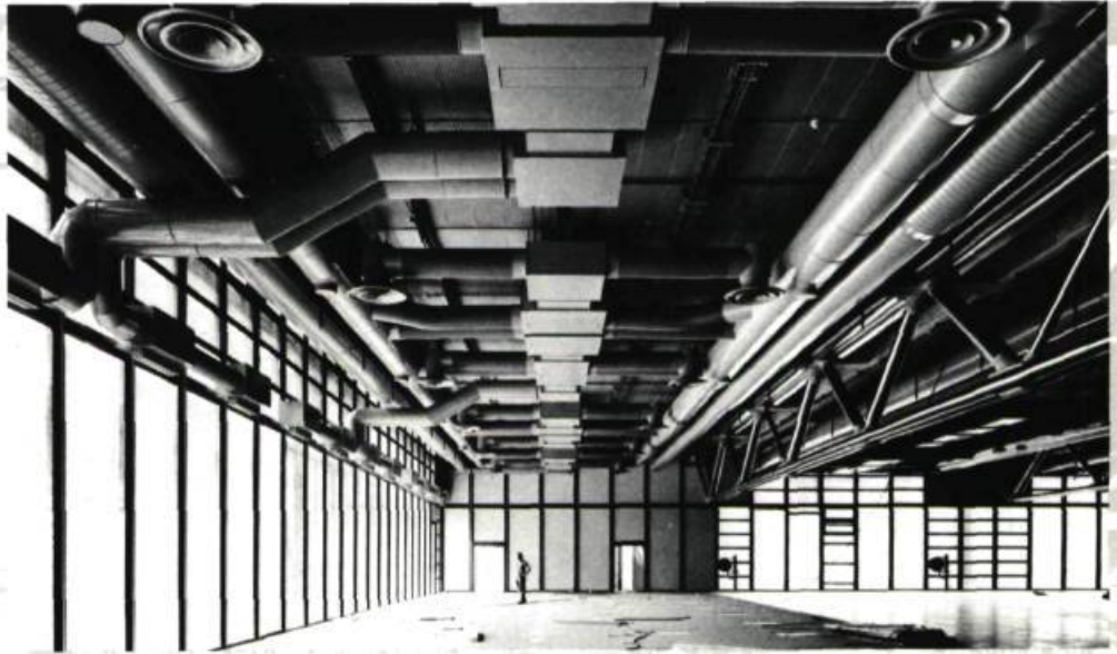
5. Vue transversale d'un étage du bâtiment avant les aménagements intérieurs. (Phot. Bernard Vincent)
