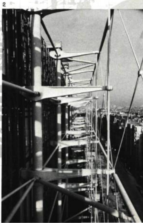
2. Façade, côté rue Beaubourg, avant l'installation des servitudes (tuyaux, monte-charge, chauffage, etc.). (Phot. W. Rich)
