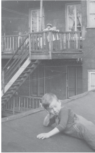
Jean Simard sur les toits des hangars de Limoilou, en 1945
