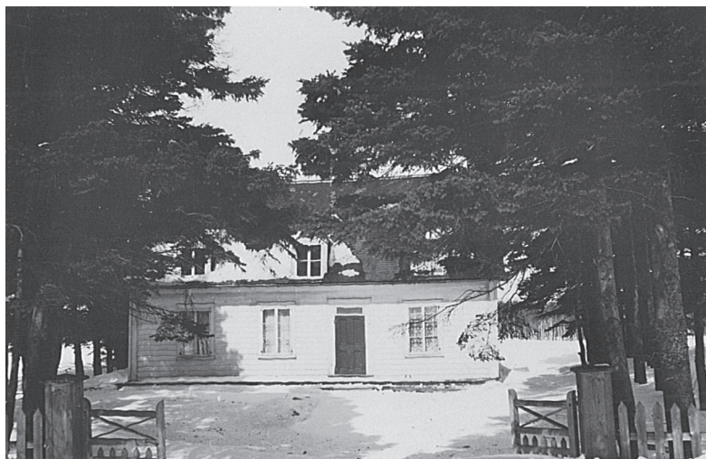
Figure 18. Cottage on Gomin Road. Maison traditionnelle sur le chemin Gomin. Québec, 1933.
