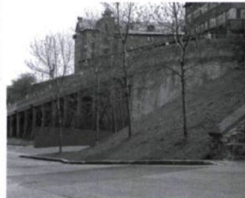
Viaduc de la côte Dinan, de la rue Saint-Paul à la côte du Palais, construit en 1897.
