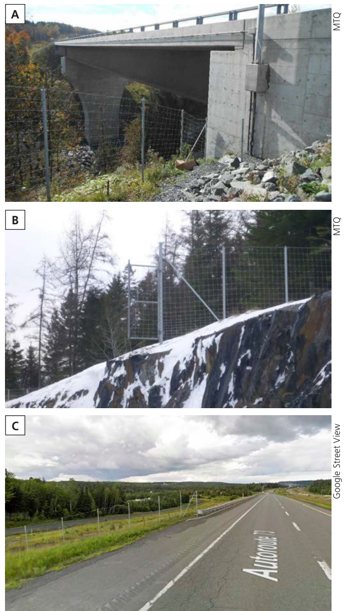
Figure 2. Photos des extrémités de clôture à cervidés : aux culées de structures (A), sur le dessus d'un cap rocheux (B) et derrière une glissière de sécurité (C).
