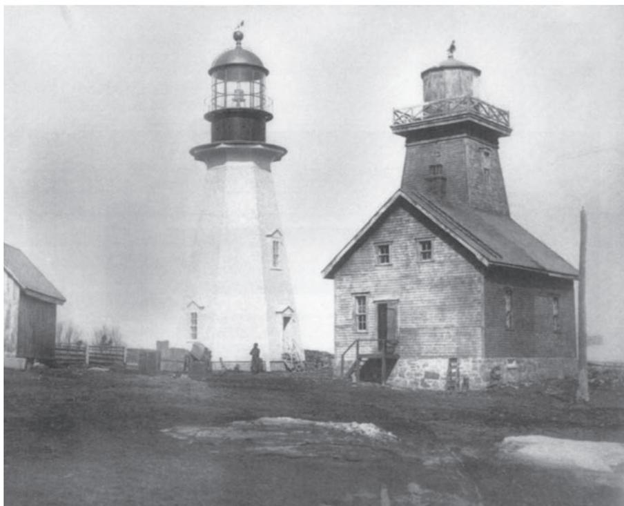
Premier phare construit en 1876 avec le phare actuel en construction. Le module à l'intérieur ainsi que la rampe autour du balcon ne sont pas installés, 1905.
