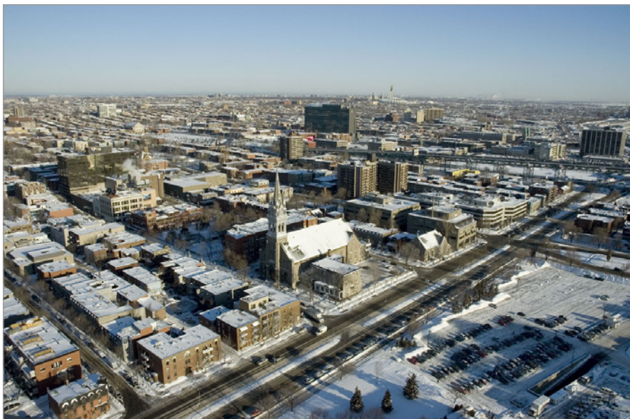
ILL. 1. MONTRÉAL. L'ÉGLISE SAINTE-BRIGIDE-DE-KILDARE, VUE D'ENSEMBLE DU SITE ET DES BÂTIMENTS, DANS LE QUARTIER CENTRE-SUD. | VINCENT LAFRANCE, 2008.
