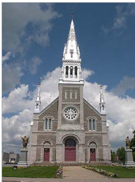
ILL. 40. LAURENTIDES. ÉGLISE SAINT-LIN. PERRAULT ET MESNARD, ARCHITECTES, 1887. | CPRQ, 2003-14-043-01.
