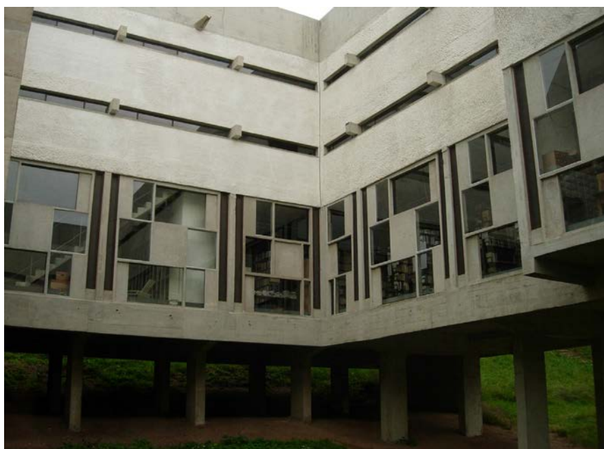
Figure 2. Une des façades intérieures du couvent de la Tourette (© F.L.C. / Adagp, Paris, 2017) portante des pans de verre “combinatoires”. Image d’Elisavet Kiourtsoglou.
