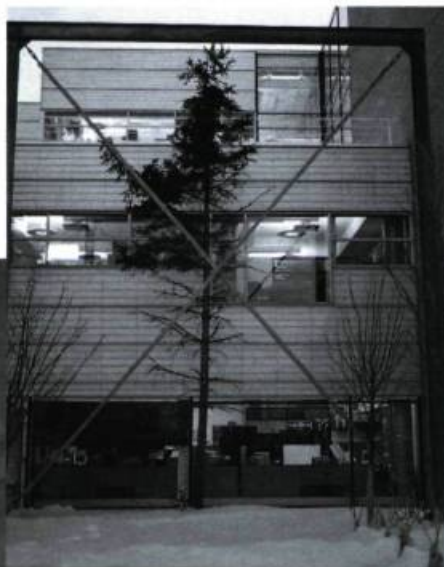
1. Situé en bordure de l'ancienne carrière Miron, le Studio du Cirque du Soleil est désigné pôle culturel de l'imposant Complexe environnemental du quartier Saint-Michel (192 hectares). « Cette place unique, ceinturant un site de transformation de matières organiques (33 millions de tonnes), a dicté l'emplacement de l'installation. » Claude BRAULT. 2. Claude BRAULT. La Patrie , catalogue produit par le Cirque du Soleil, Montréal, 2000, p.2. 3. Patrick BEAULIEU. Op. cit. , p.3. 4. Claude BRAULT. Op. cit. , p.3.
