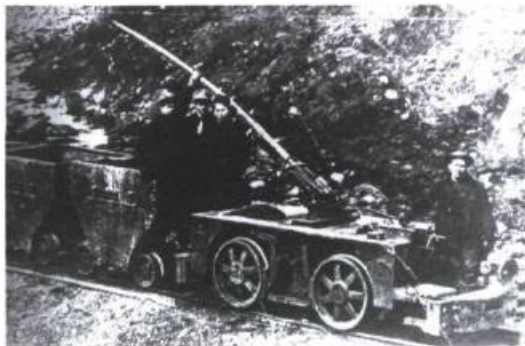
Tracteur électrique à trolley à la mine Eustis. H.J. Cordy. Tiré de G. Ross, Trois villages miniers des Cantons l'Est au Québec 1863-1972 , Albert Minos, Capelton, Eustis, Sherbrooke, G'G'C', 1996, p.123.
