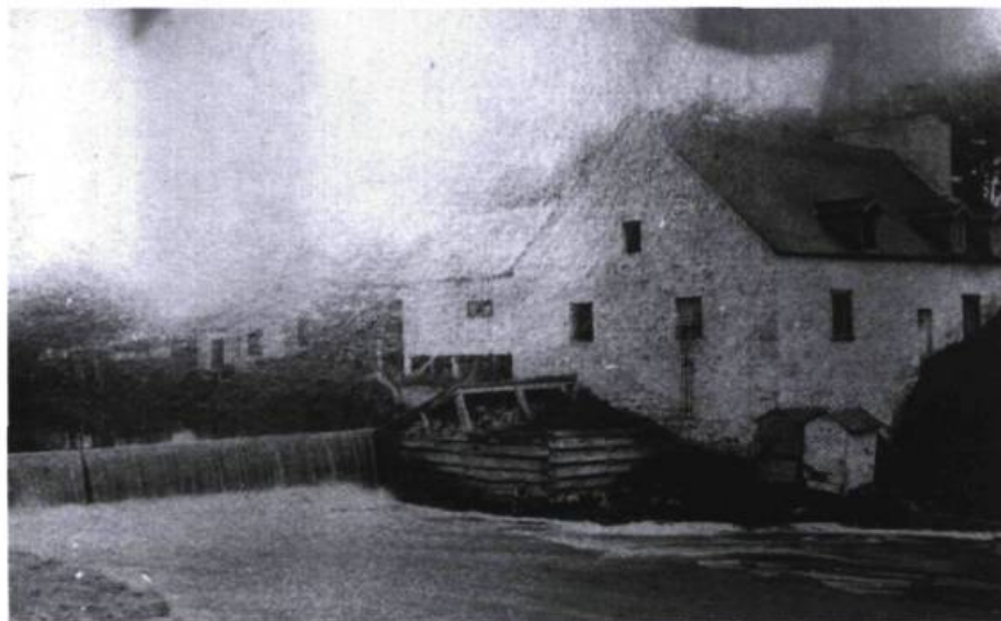
Cette photographie datant de 1898 nous montre le moulin Légaré tel qu'il fut « remis à neuf » par l'entrepreneur Louis Ouimette à la demande de Pierre Lavolette.
