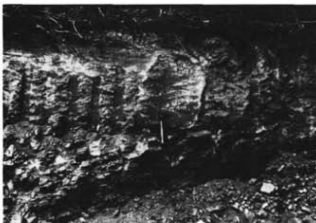
FIGURE 15. Altération dans les schistes argileux et les mudstones près du camping du Cap-Bon-Ami. Il s'agit d'une argile compacte qui passe graduellement à la roche saine en profondeur. Les lignes parallèles dans l'argile sont superficielles.
