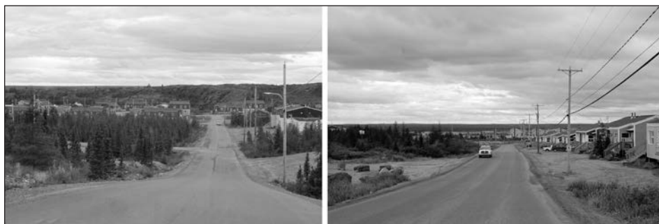
Figure 6. Sections de rues non construites à Kuujjuaq (Rochette 2015).
