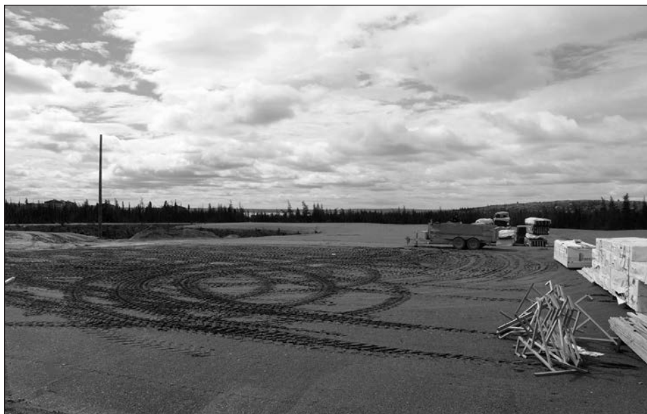
Figure 12. Les radiers de nouveaux quartiers de Kuujuaq, avant la construction de maisons (Rochette 2015).
