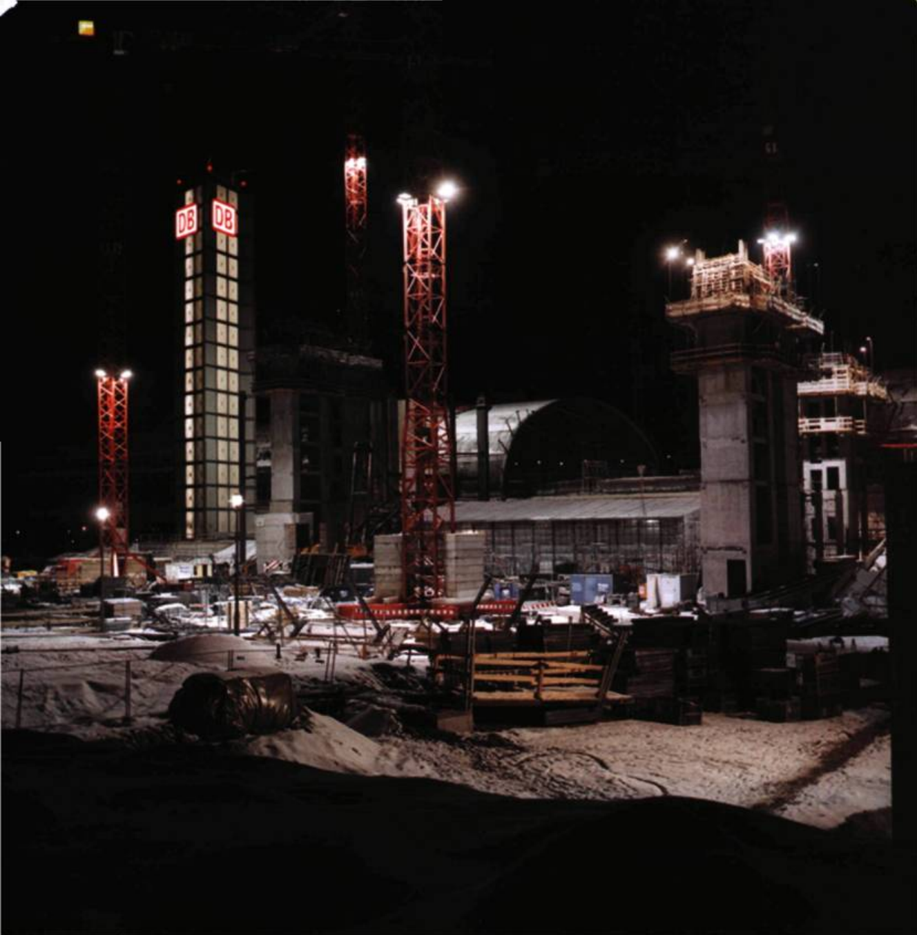
Karen Linke, Ballet de grues , de la série Berliner Baustellen , 2004-2005. Chantier du Lehrter Bahnhof, qui deviendra la gare principale de Berlin d'ici 2007; suscitant moults débats, elle est censée devenir l'axe nord-sud/est-ouest du trafic ferroviaire européen. Chantier Lehrter Bahnhof, à - 20° C, à Berlin, le 26.02.2005. Impression numérique au jet d'encre, papier 300 gr. mat/maxi résolution; 80 x 80 cm. © Karen Linke.
