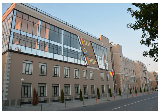
IMAGE 10 : Université d'Etat à Tskhinvali, second bâtiment
