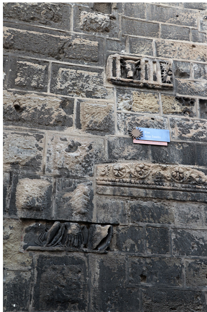
IMAGE 9 : Le mur de la tour du Palais des Archevêques Source : Olivier Soleil, 2022
