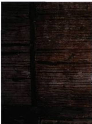
Les lattes de bois sur lesquelles on posait le crépi ou le plâtre étaient fendues jusque vers 1870.
