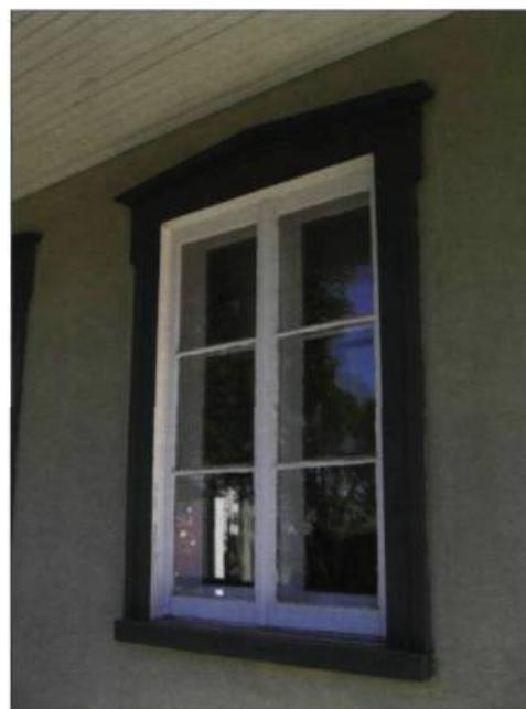
L'encadrement assure l'étanchéité de la ligne de rencontre entre la fenêtre et le mur de crépi, en protégeant ce joint de construction.
