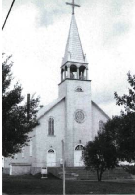
Ces églises au plan semblable ne se distinguent bien souvent que par l'ordonnance du mur de façade et par le traitement très simple du clocher. L'église Sainte-Rose de Poularies, en Abitibi, construite en 1927. (photo: ministère des Affaires culturelles)
