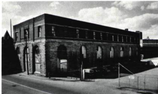
La gare Dalhousie, dans le secteur est du Vieux-Montréal, avant sa restauration. Vue de la cour. (photo: Héritage Montréal)
