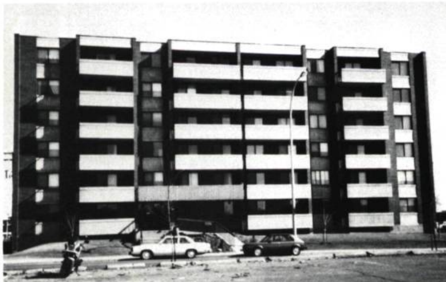
Un immeuble de typologie moderne avec ses grands balcons de béton accentuant les lignes horizontales qui semblent se répéter à l'infini. (photo: M. Leduc)
