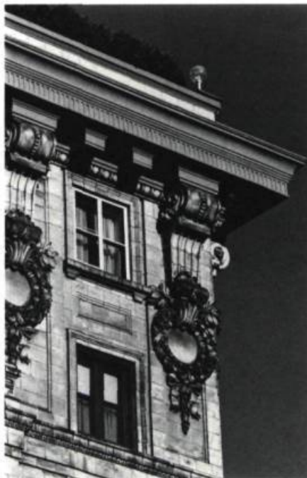
Le Linton. Détail de la corniche et de l'ornementation en terre cuite vitrifiée. Une terrasse a été aménagée sur le toit. (photo: B. Ostiguy)
