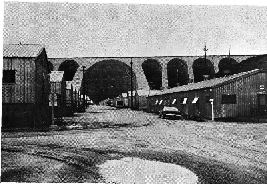
Photo 1 Le chantier de Manic 5.
