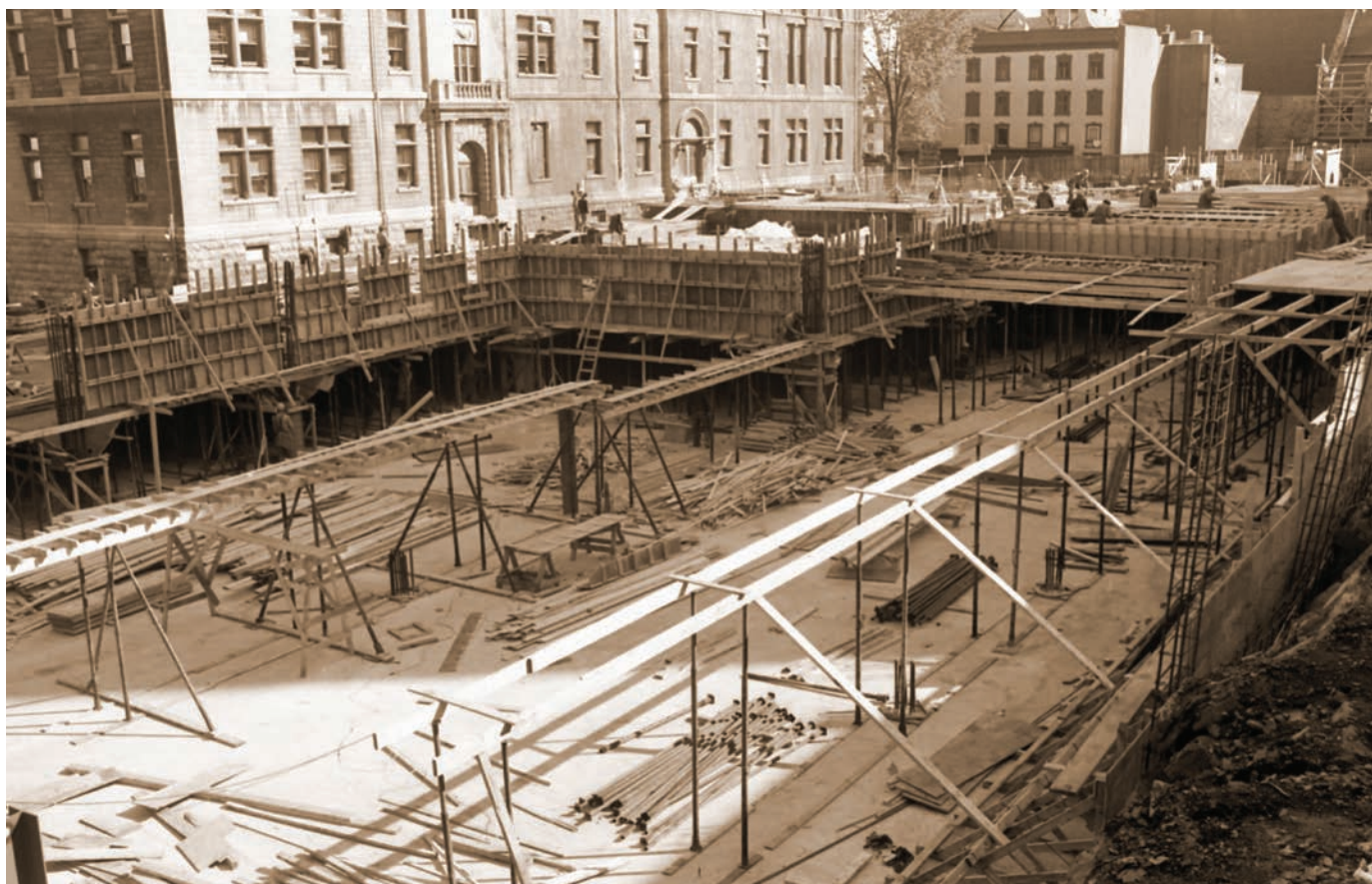
Excavation pour la construction de l'autoroute Dufferin-Montmorency. (Centre d'archives de Québec, Bibliothèque et Archives nationales du Québec).
