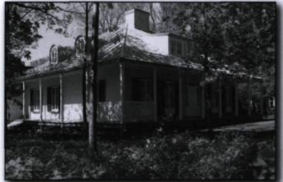
Maison Henry-Stuart, classée monument historique. Photographie de Marie-Claude Côté, 2003. Répertoire du patrimoine culturel du Québec . (Ministère de la Culture, des Communications et de la Condition féminine).
