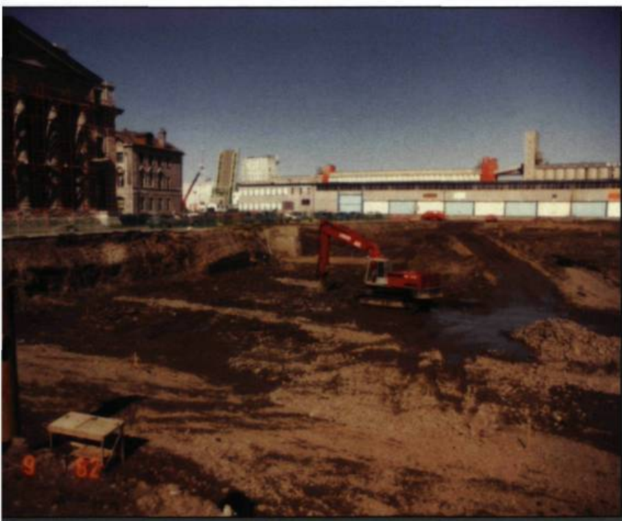
■ Chantier de l'Agora du Vieux-Port devant l'édifice de la douane, en 1982. (Banque d'images de Cap-aux-Diamants, fonds Serge Juneau, PH2000-2763).
