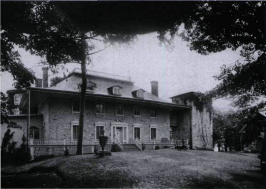
La façade nord du manoir, vers 1929. Vers la gauche se profile le salon hors-cœuvre de 1881; à l'opposé on voit la tour carrée de la bibliothèque. À l'extrême droite: la façade du musée familial édifé en 1880. (Archives nationales du Canada).
