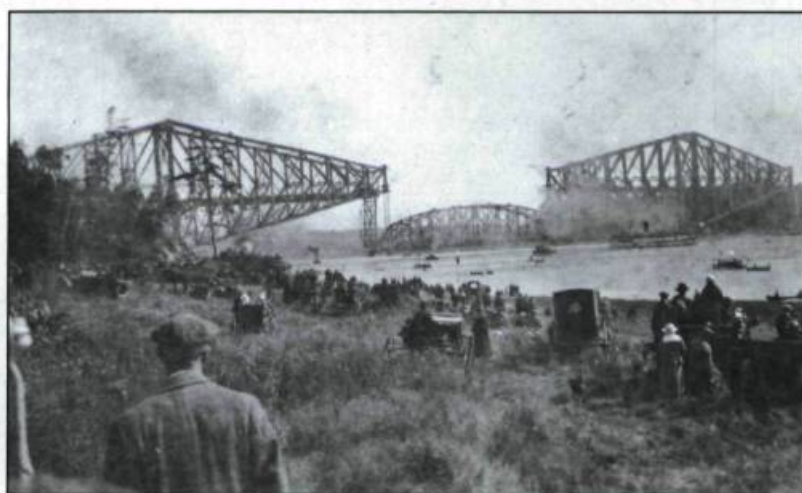
Seconde tentative réussie de raccordement de la travée centrale aux bras cantilevers le 17 septembre 1917. De nombreuses personnalités assistent à l'événement. (Carte postale, collection Yves Beauregard).
