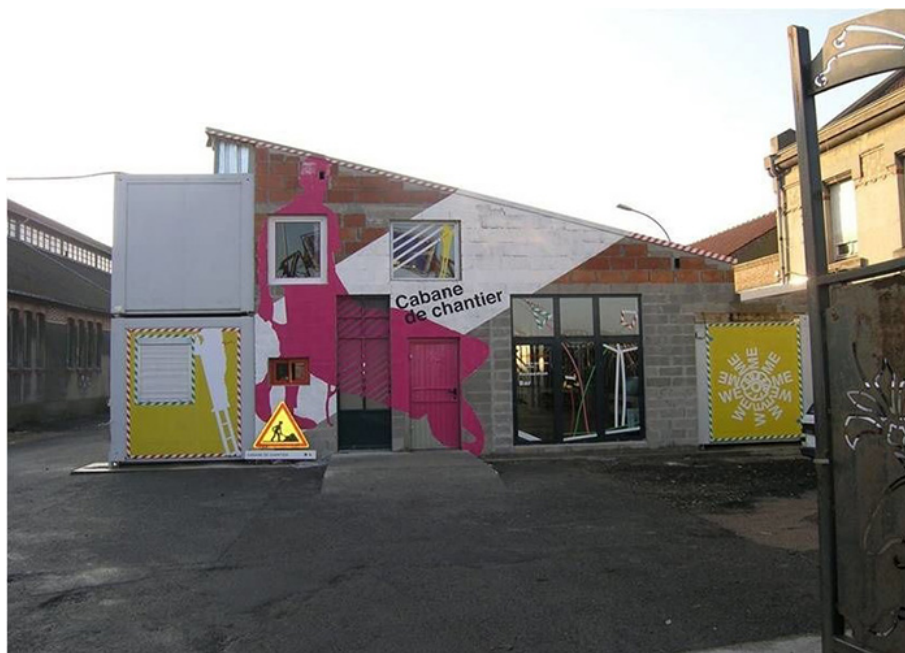
Construire, Cabane de chantier , Le Channel à Calais (2007)
