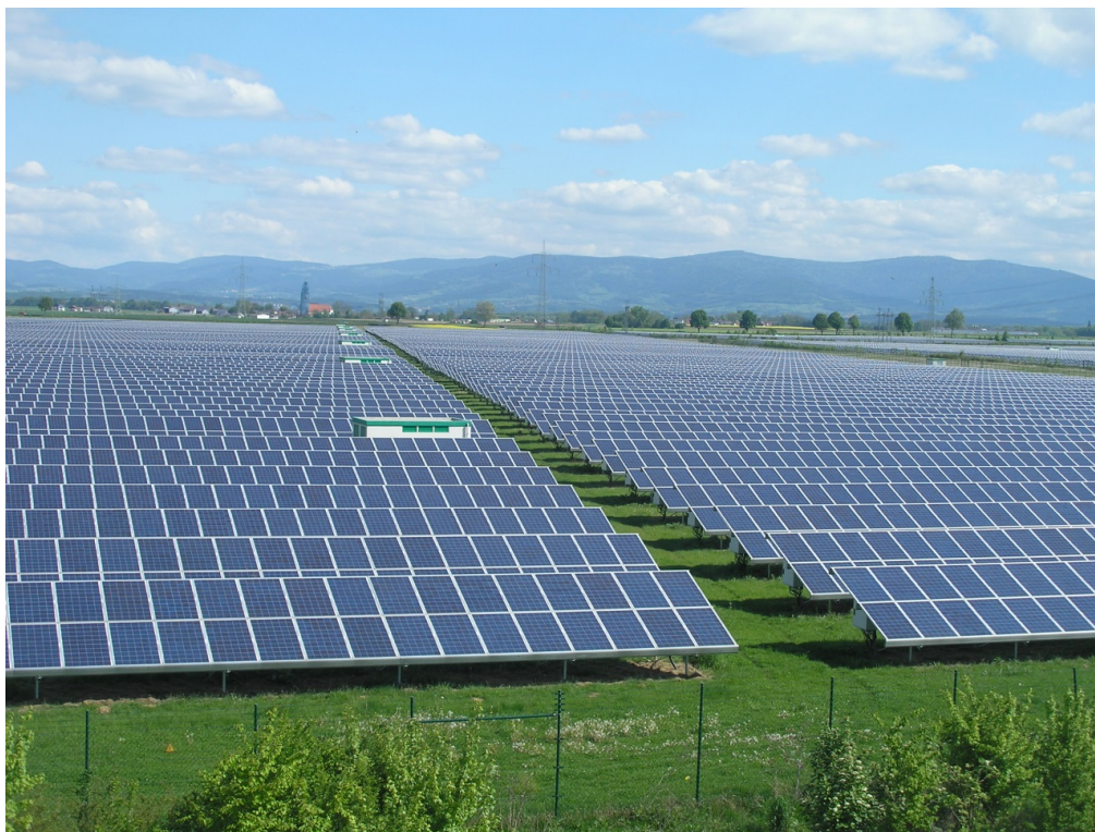
Figure 8. Parc solaire photovoltaïque de Straßkirchen, près de Straubing en Bavière.
