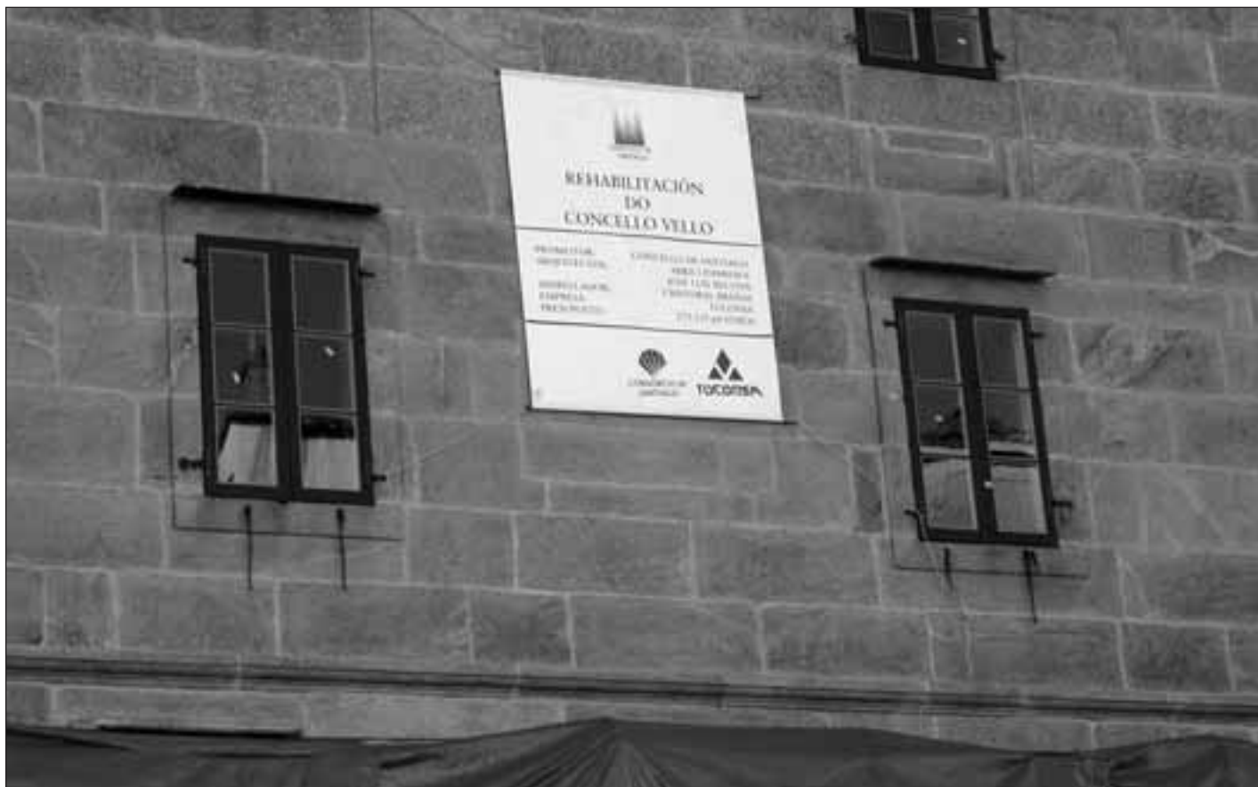
Ancienne mairie, réhabilitée par le Consorcio.
