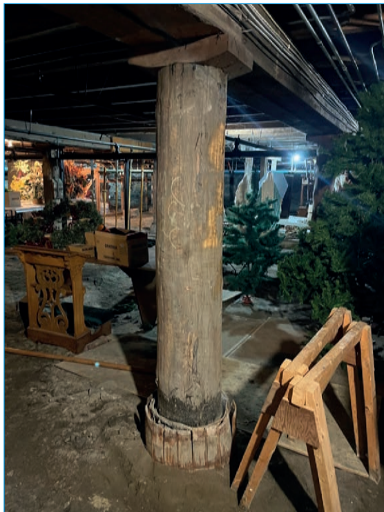
ILL. 20. COLONNE STRUCTURALE DANS LE SOUS-SOL DE L'ÉGLISE SAINT-ALPHONSE, 2022. SAMUEL DUBOIS & HEATHER BRAIDEN.
