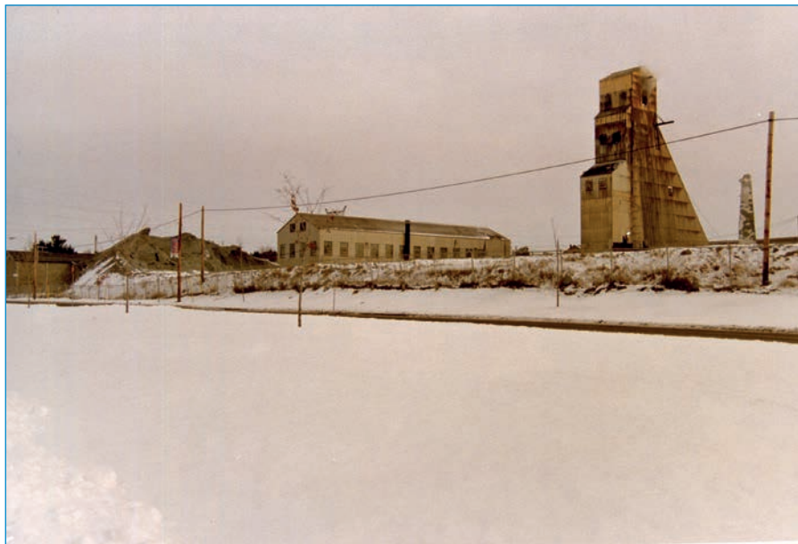
ILL. 14. INSTALLATIONS MINIÈRES DE LA MINE KING, 1990. CENTRE D'ARCHIVES DE LA RÉGION DE THETFORD – FONDS JEAN-CHARLES POULIN.
