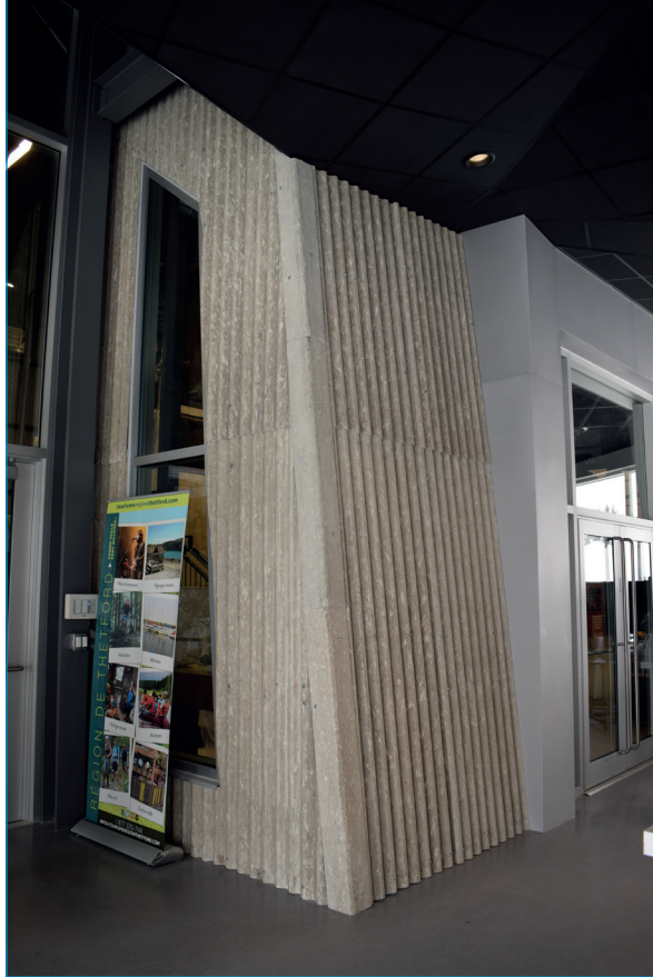
ILL. 13. PANNEAU EN FIBRES D'AMIANTE DANS LE VESTIBULE DU CENTRE KB3, 2022. SAMUEL DUBOIS & HEATHER BRAIDEN.
