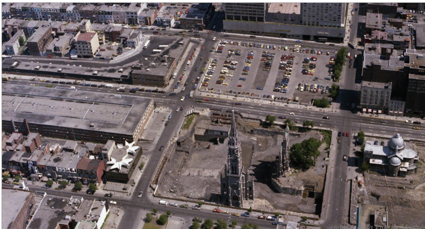
ILL. 18. ÉGLISE SAINT-JACQUES ET CHAPELLE NOTRE-DAME-DE-LOURDES APRÈS LES DÉMOLITIONS (9 JUIN 1976). | VINCENT MASSARO. SOURCE : ARCHIVES DE LA VILLE DE MONTRÉAL.
