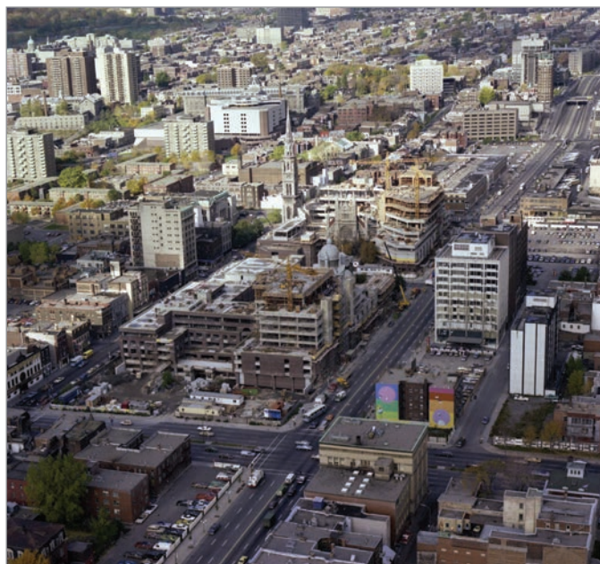
ILL. 25. CONSTRUCTION DE LA PHASE 1 DE L'UQAM (V. 1977). | ARCHIVES DE LA VILLE DE MONTRÉAL.
