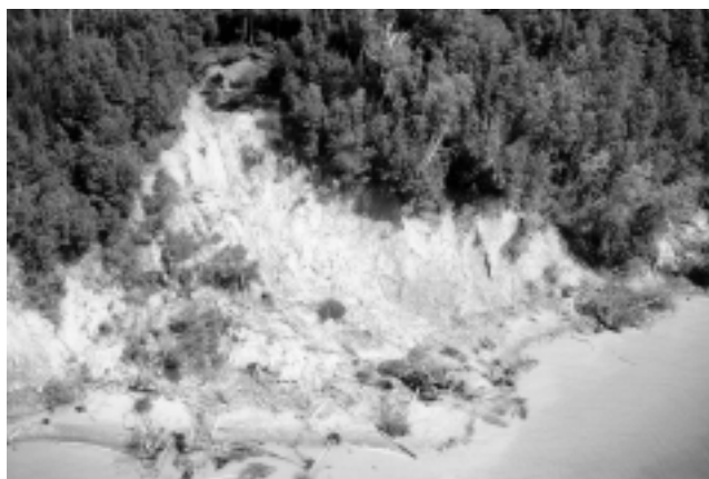
FIGURE 5. Glissement dans une terrasse argileuse entraînant la chute des arbres (rive droite de la rivière Broadback).
