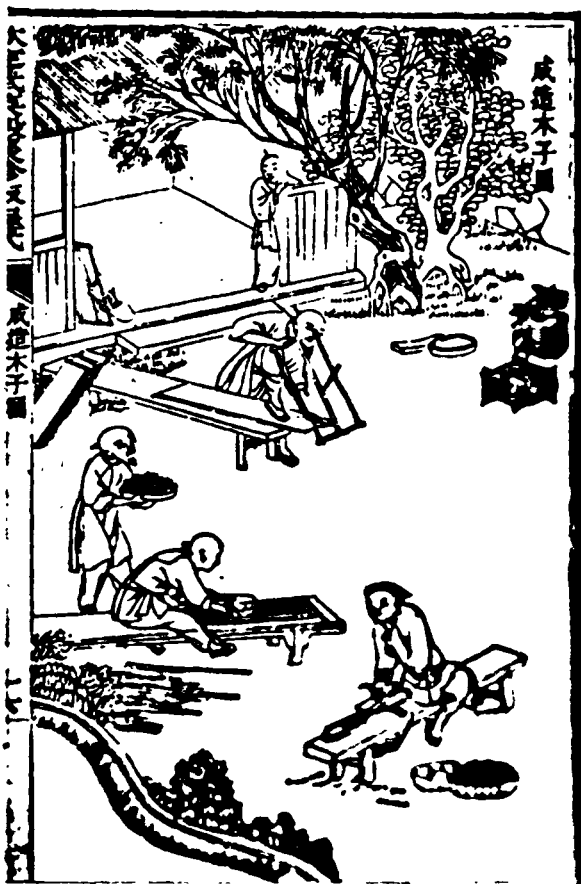
FIGURE 5 — Illustration de la fabrication de caractères mobiles tirée du Manuel des procédés typographiques , publié en 1776.
