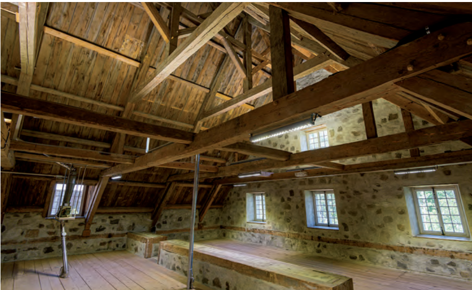
Un traitement par contraste avec les structures anciennes a été privilégié pour intégrer les nouveaux équipements au décor patrimonial.
