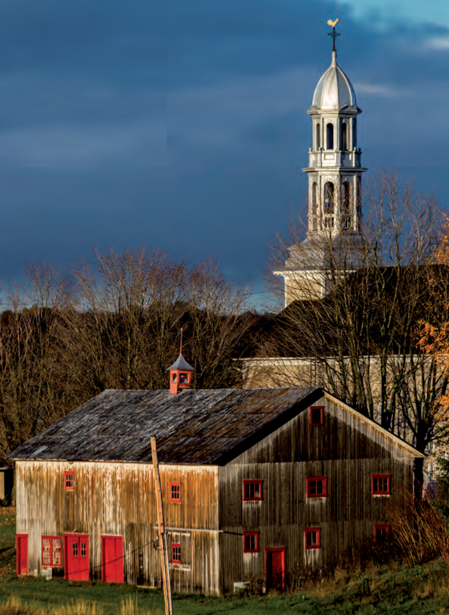
La grange à dîme de Saint-Joseph-de-Kamouraska, gagnante du concours Sauvez un bâtiment de chez vous, en 2012, a prouvé que ce type de construction peut soulever l'enthousiasme de la population.
