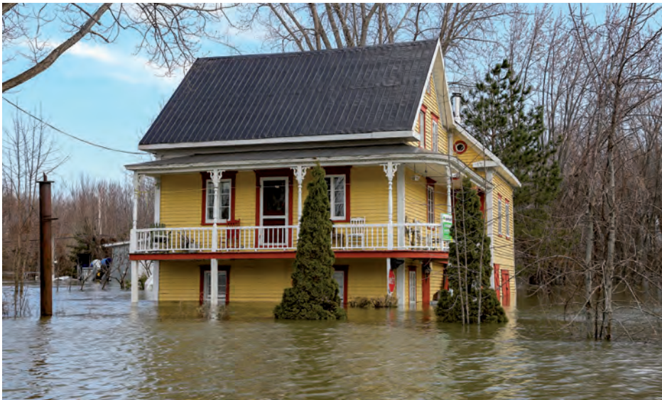
Incluse dans le répertoire du patrimoine bâti de la MRC de Pierre-De Saurel, cette maison située sur l'île d'Embarras a connu plusieurs inondations au fil du temps. Sa galerie extérieure nichée à l'étage permettait aux résidents de s'y réfugier en cas de crue.
