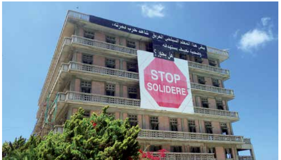
L'hôtel Saint-Georges, conçu par Antoine Tabet, un des premiers architectes modernes de la région, a été ravagé durant la guerre et attend encore sa réouverture. Il fait l'objet d'une bataille judiciaire entre son propriétaire et Solidere, une société qui a développé le centre-ville de Beyrouth en démolissant plusieurs bâtiments historiques.
