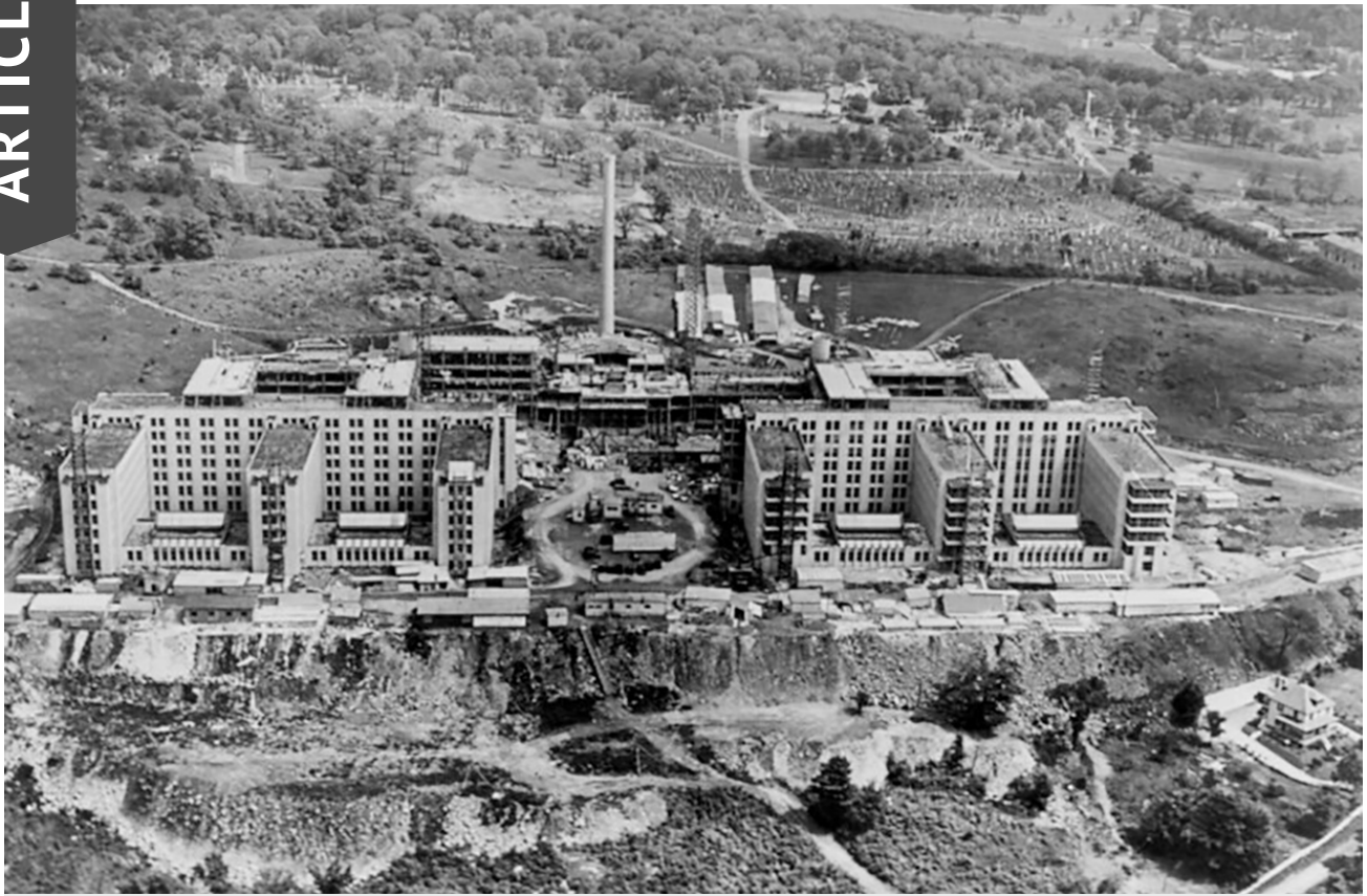
Chantier du nouveau pavillon de l'Université de Montréal, interrompu en 1931 et repris en 1941. (Archives de l'Université de Montréal).
