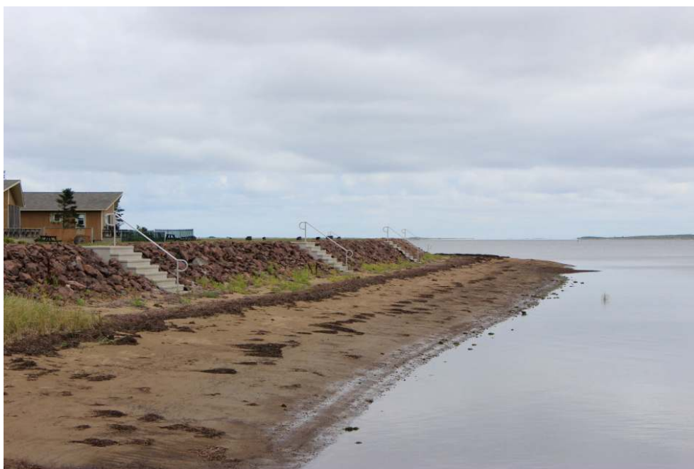
Figure 14. Les chalets du Havre, Richibuctou, construit sur de vieux débris de bran de scie.
