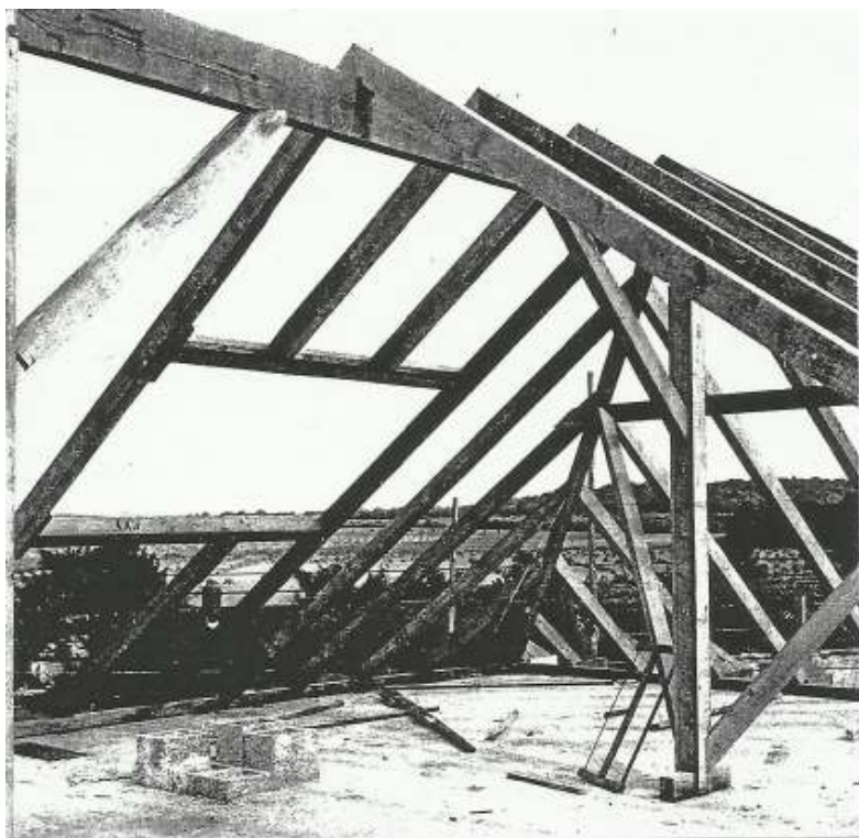
Figure 2. Installation de la charpente sur le chantier des 200 logements à Creil / Setting up the frame in the 200 houses construction site in Creil.
