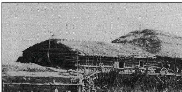
5. Maison-étable construite vers 1893 par M. Ogier dans la région de Montmartre.
