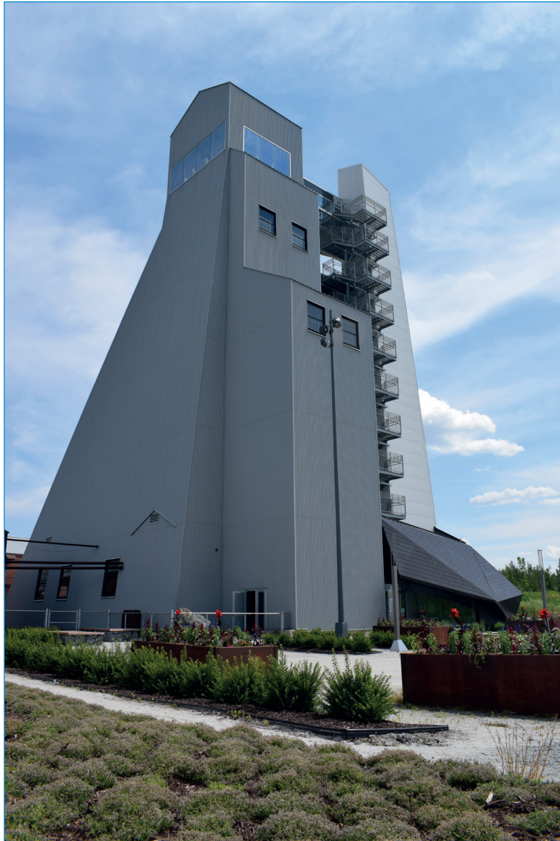
ILL. 3. BÂTIMENT PRINCIPAL DU CENTRE HISTORIQUE KB3 (ANCIEN CHEVALEMENT), 2022. SAMUEL DUBOIS & HEATHER BRAIDEN.
