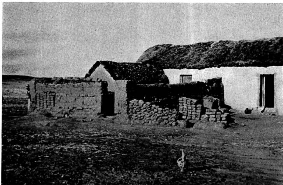
Ferme typique à Chayanta dans le département de Potosí. Le toit de la maison est en chaume et les murs en adobe.
