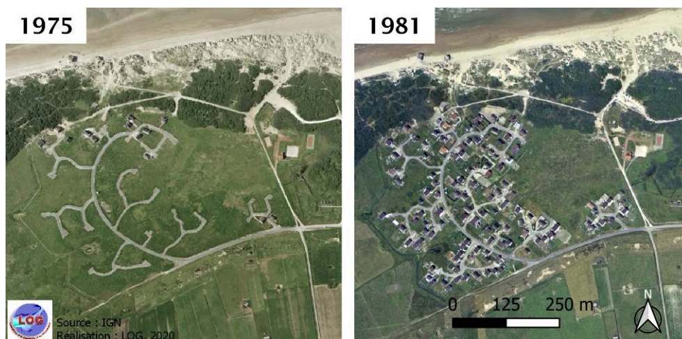
Figure 3. Photographies aériennes illustrant, durant deux décennies, l'évolution du lotissement des Ecardines, en arrière d'un cordon dunaire en érosion.
