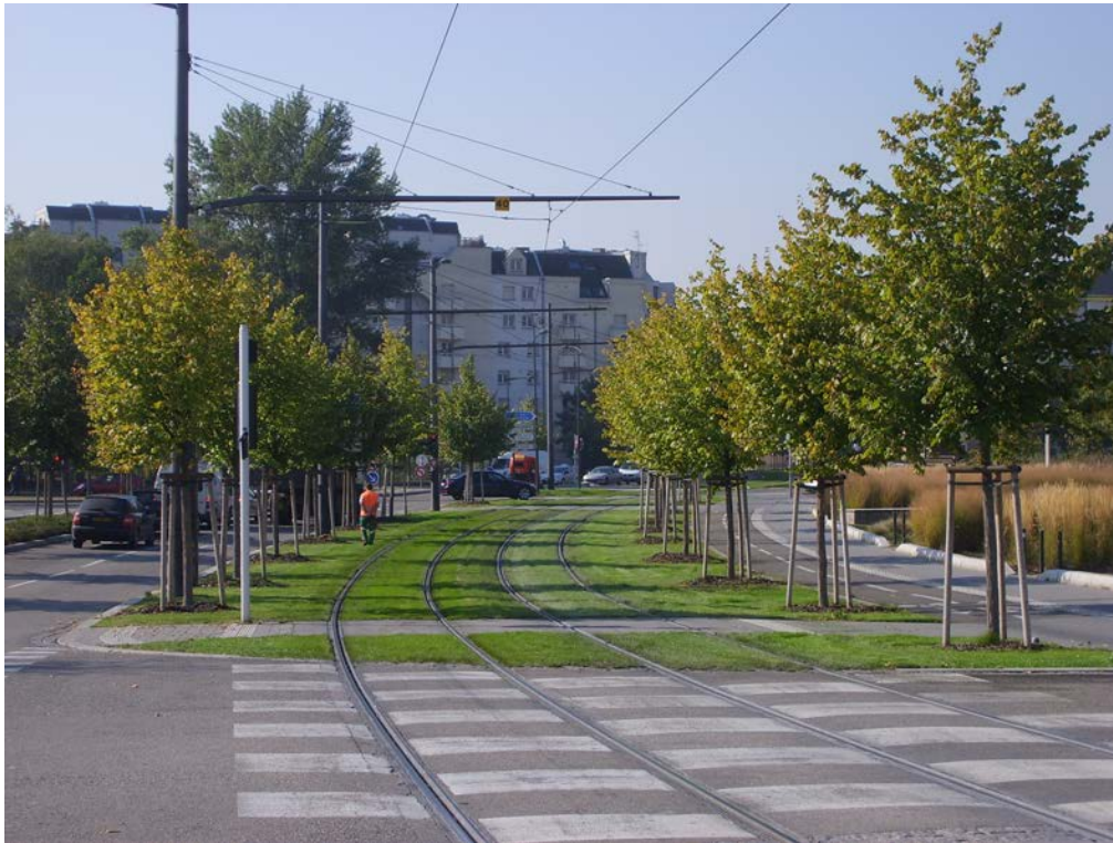
Figure 6. Verdissage des voies de tram à Strasbourg : engazonnement des emprises et plantations d'arbres, arrêt Pont Churchill
