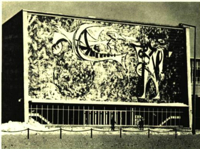
Pavillon des Sciences — Université Laval de Québec. Architecte : Malguy — Murale en céramique de Jordi Bonet.
