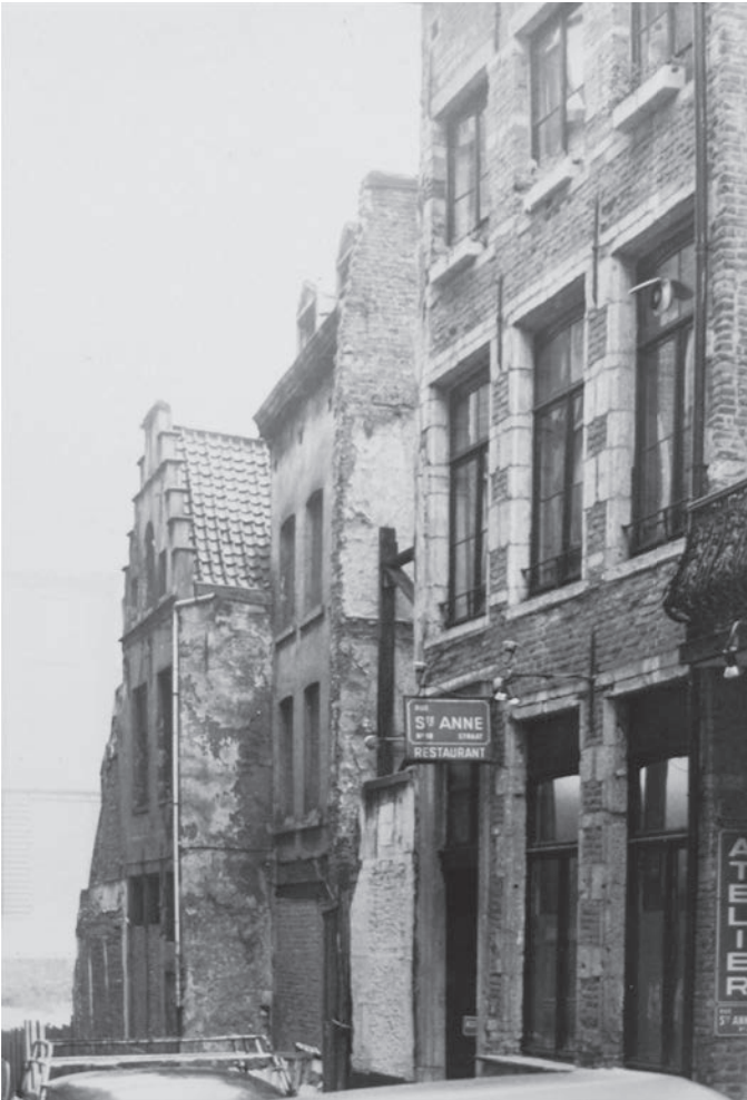
Figure 15 : Photographie des maisons n°10 et 12-14, rue Sainte-Anne, avant restauration, sd, Travaux Publics 95173, AVB.
